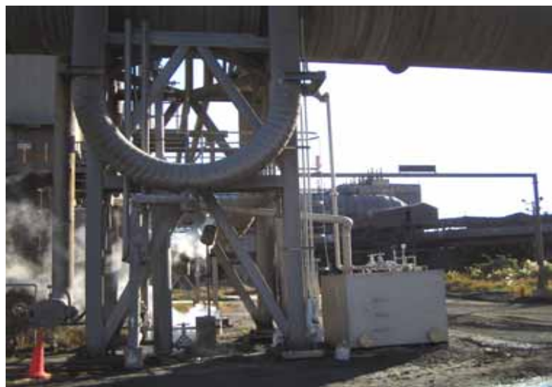
写真14 製鋼ガス凝縮水抜き取り装置の増設
