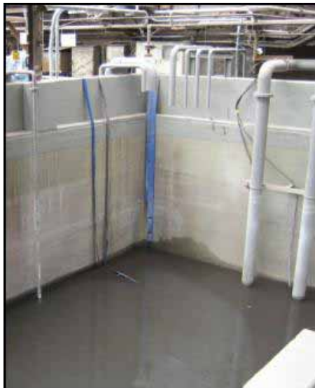
12-b. 貯留槽内側
