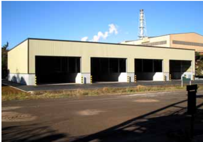
写真3 スラジ仮置き場
