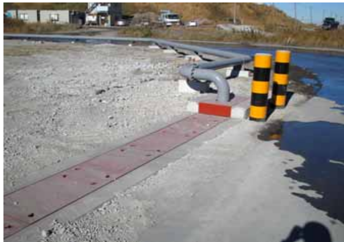
13-c. 埋設配管U字溝化
