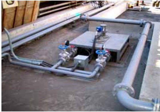
13-a. 防液堤内集水
