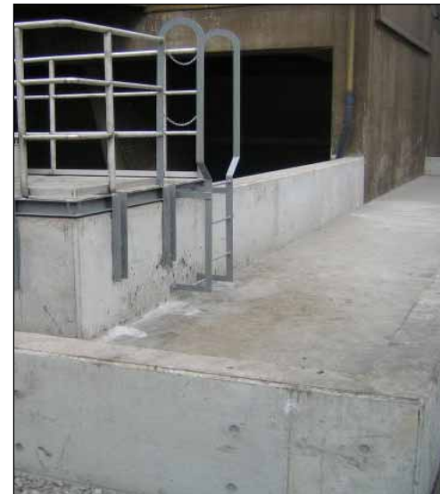
12-c. 貯留槽防液堤
