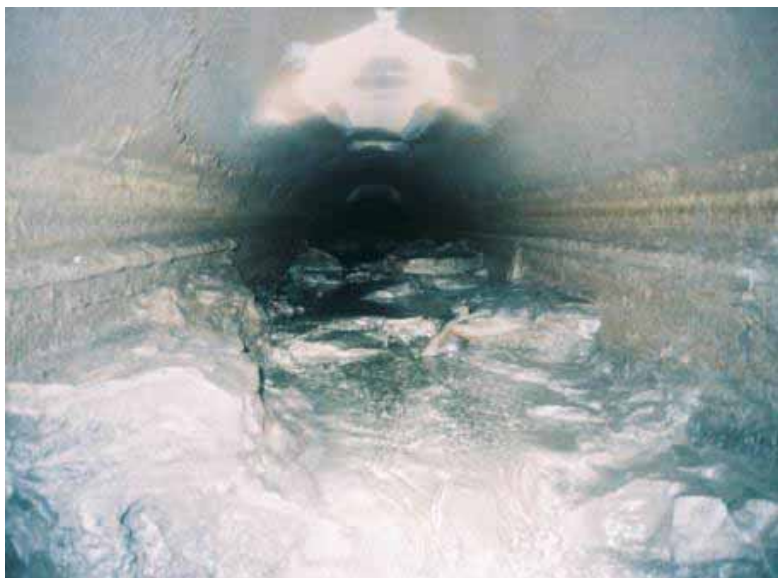
マンホールB ~ C
