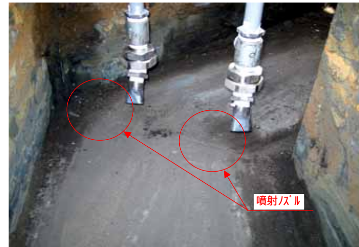
8-b 湿式除塵機トワ内洗浄ノズル
