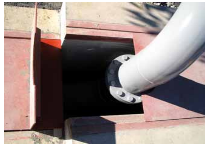
13-d. 埋設配管U字溝化
