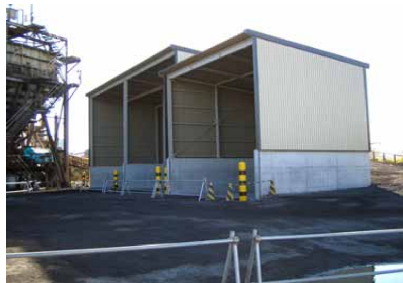
写真15 塊原料ヤードへの屋根・壁の設置
